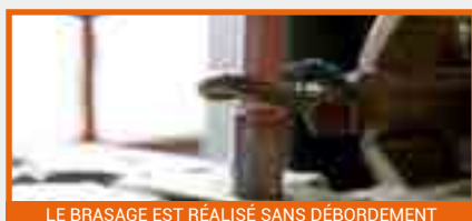
LE BRASAGE EST RÉALISÉ SANS DÉBORDEMENT
